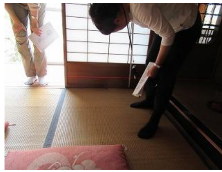
建物の傾きを調べています。
