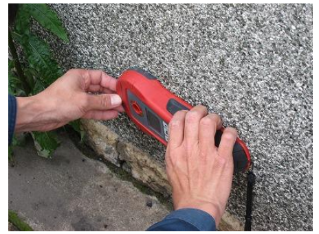
基礎の鉄筋の有無を調べています。
